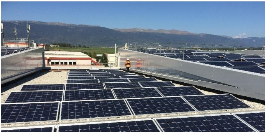
Le fournisseur d'énergie genevois SIG exploite une installation PV avec communauté d'autoconsommation située dans la zone industrielle de Satigny (GE). L'électricité photovoltaïque est utilisée dans le bâtiment à hauteur de 45 %, à la fois pour le fonctionnement de la pompe à chaleur et pour la consommation en électricité des dix locataires commerciaux. SIG a reçu le Prix Solaire 2017 pour ce projet.
